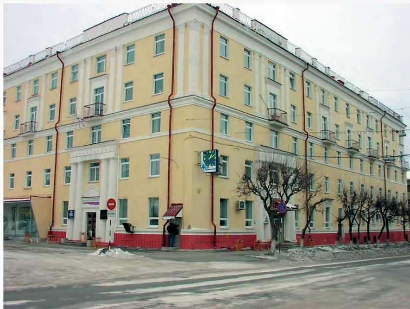
г. Снежинск. Здание отделов управления
