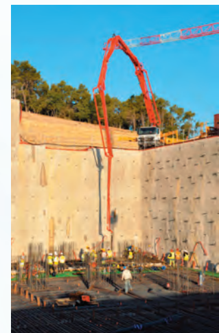
Котлован под ИТЭР забетонирован
