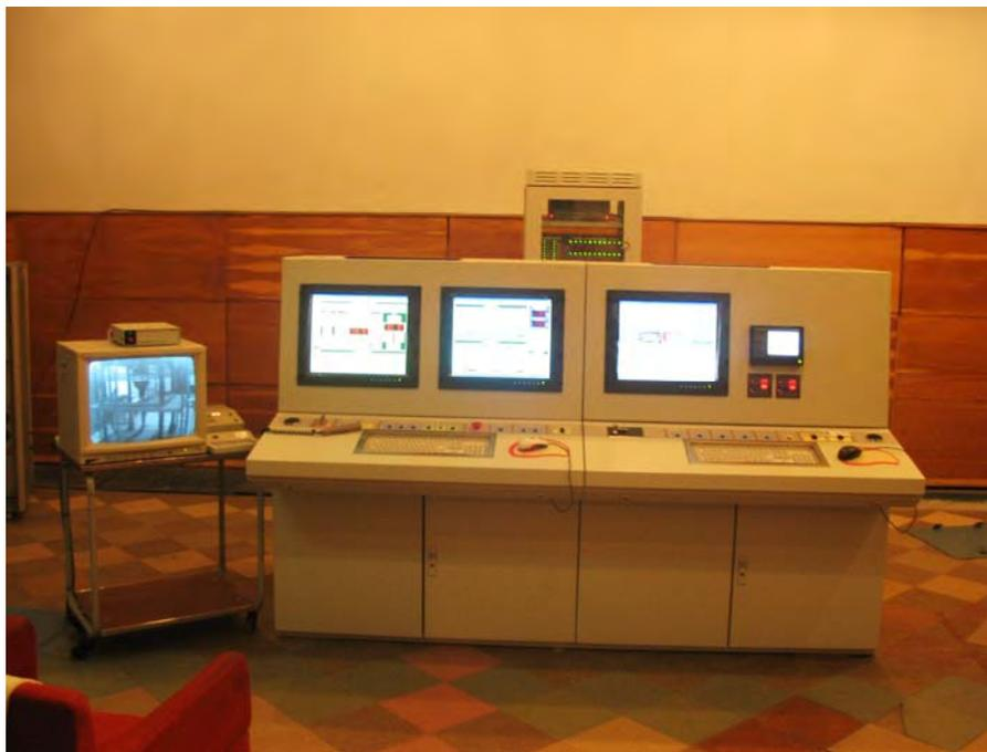
Рис. 3. Вид пульта управления реактором ПРИЗ-М. На заднем плане приборная стойка
