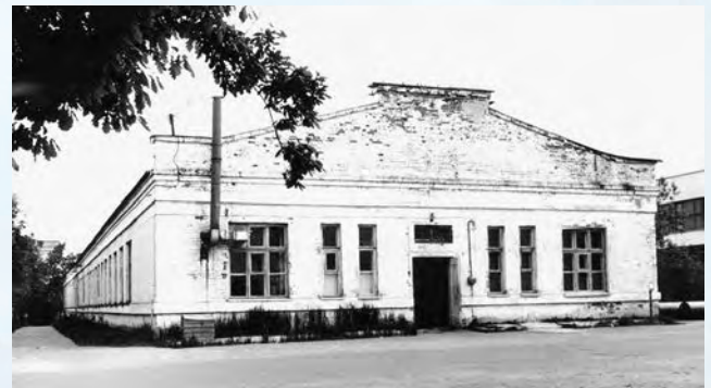
Здание цеха завода «Коммунист»
