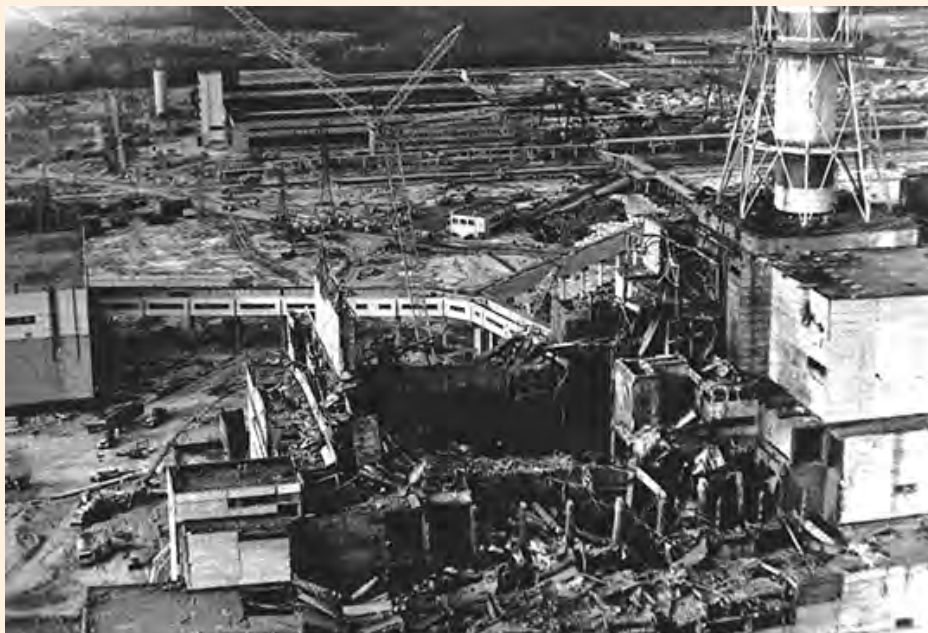
Реакторное отделение 4-го энергоблока после взрыва
