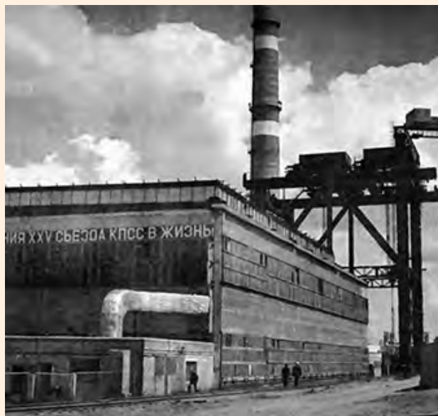
Здание второй очереди ЧАЭС. 1975 г.
