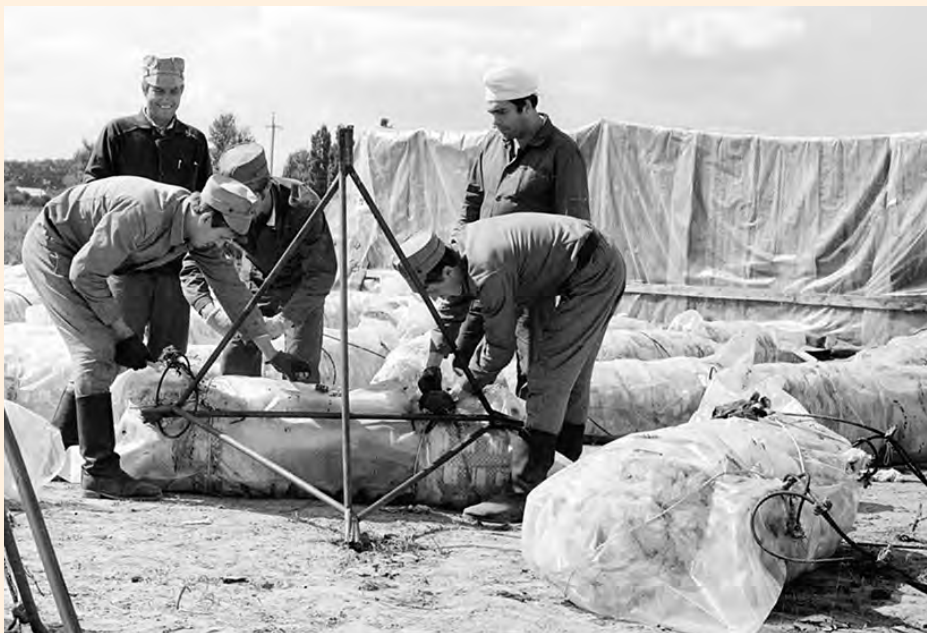
Подготовка «промокашек» для дезактивации кровли машинного зала ЧАЭС. 1986 г.
