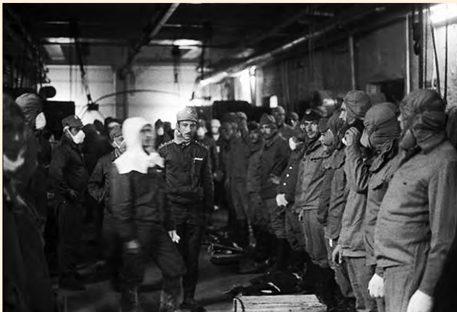
Инструктаж личного состава перед выходом на крышу машзала 4-го энергоблока. 1986 г.
