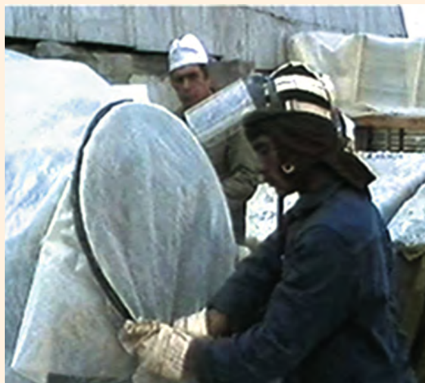
Подготовка фильтров для установки в вентиляционных трубах 3-го энергоблока. 1986 г.
