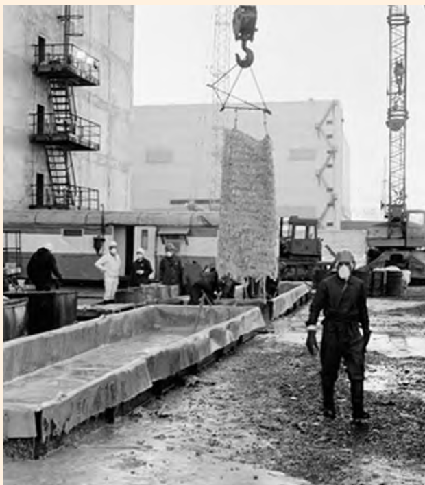
Подготовка «промокашек» для дезактивации кровли 3-го энергоблока ЧАЭС. 1987 г.
