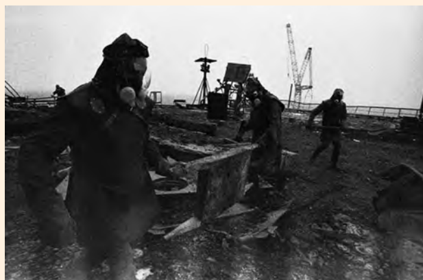
Дезактивация кровли машзала 4-го энергоблока ЧАЭС. Июль 1986 г.
