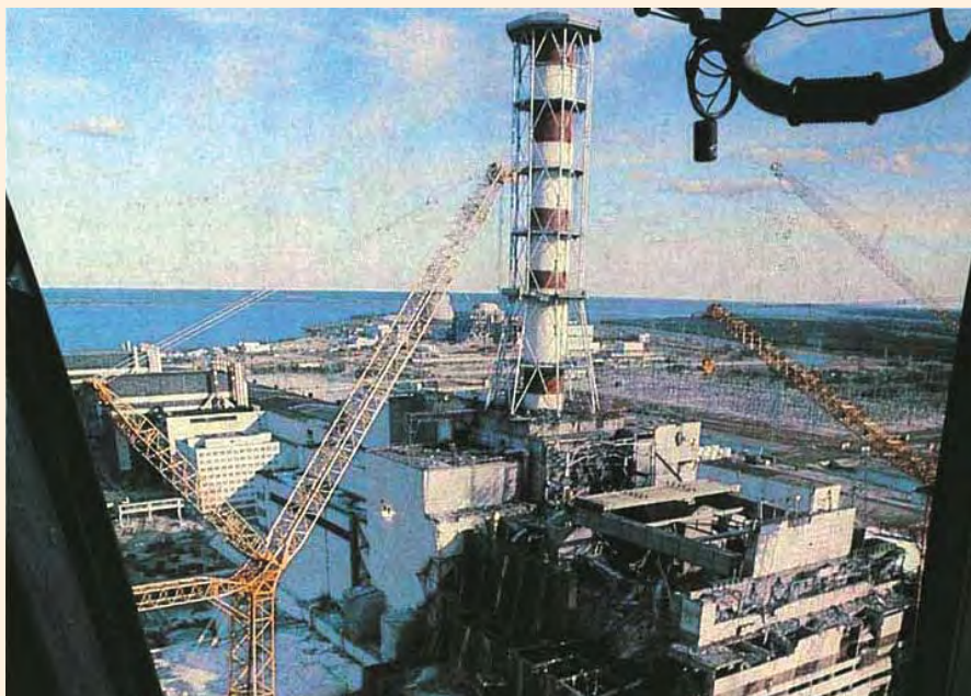
Аварийное здание 4-го энергоблока. Вид с вертолета.
