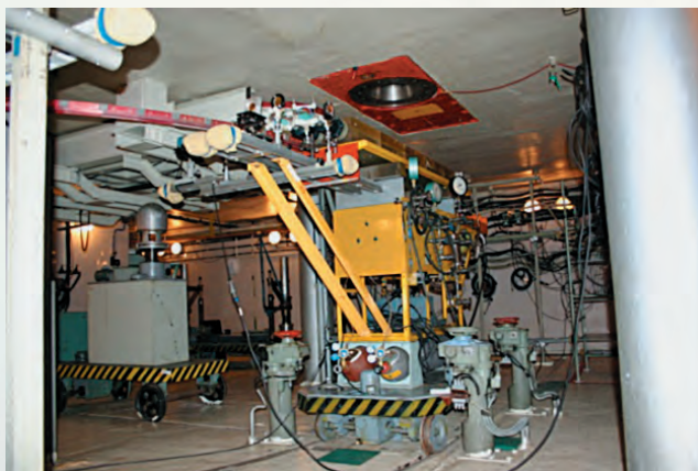
Рис. 2. Нижний зал ВИР-2М (под ПСК – двухканальная лазерная установка ЛУНА)
