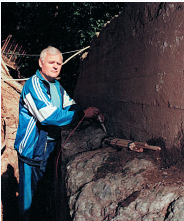
В. И. Зотов за подготовкой зарядов перед подрывом стены у входа в Саровские подземелья, август 2000 г.
