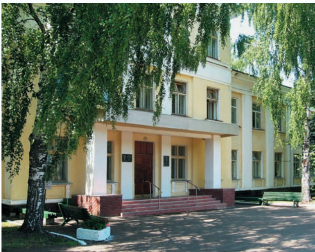
Заводоуправление ЭМЗ «Авангард»
