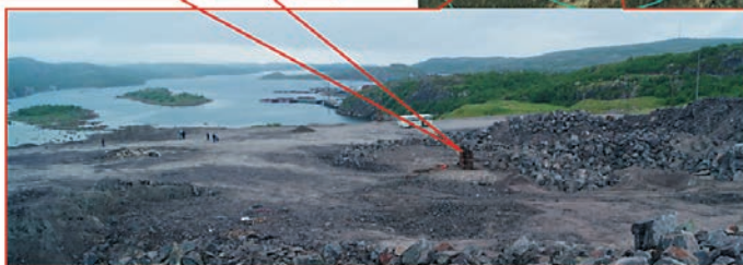
Рис. 4. Место проведения работ и объект взрывной резки
