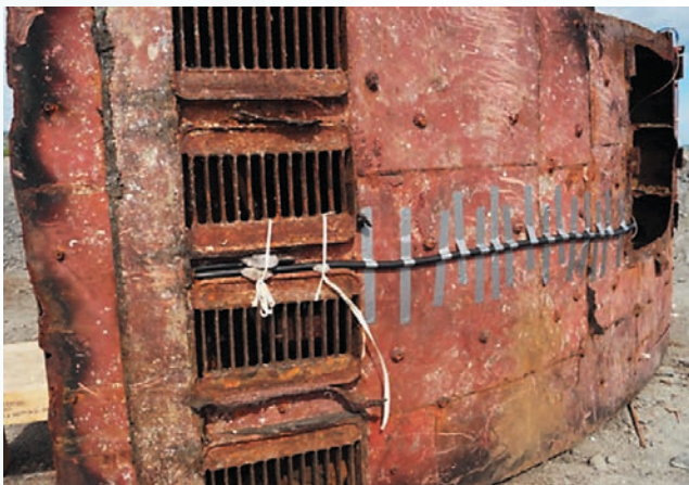
Рис. 7. Резка внешнего «легкого» корпуса шнуровым кумулятивным зарядом ( m_{ВВ} = 0,5 кг на погонный метр)
