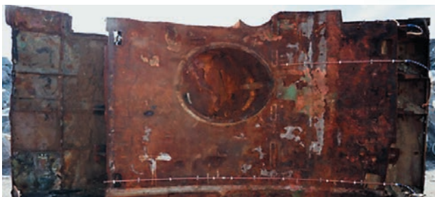
Рис. 5. Этапы резки «прочного» корпуса (сталь АК-29, 40 мм): а – первый этап, б – второй этап ( m_{ВВ} = 2 кг на погонный метр)
