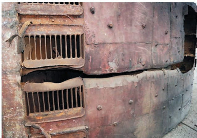
Рис. 7. Резка внешнего «легкого» корпуса шнуровым кумулятивным зарядом ( m_{ВВ} = 0,5 кг на погонный метр)
