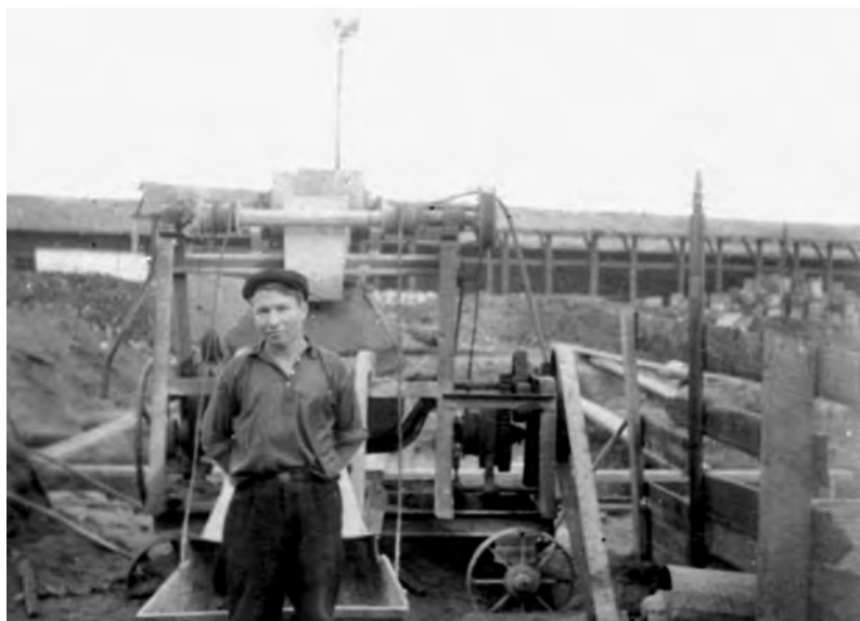
Около растворобетонотомешалки на станции Москва-Товарная Казанской железной дороги
