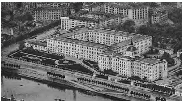
Западный и центральный корпуса Императорского Воспитательного дома
