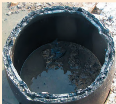
Общий вид кромки реза нижней части
