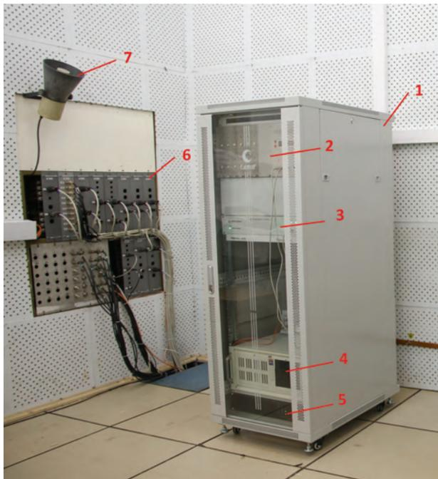
Рис. 4. Стойка управления АСУК: 1 – стойка управления САВЕУС, 2 – ПГС, 3 – выдвижная панель с электронными блоками АСУК, 4 – ЭВМ, 5 – источник бесперебойного питания, 6 – переходное окно фильтров, 7 – громкоговоритель
