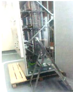
Рис. 2. Изготовление помоста под стремянку для монтажа
