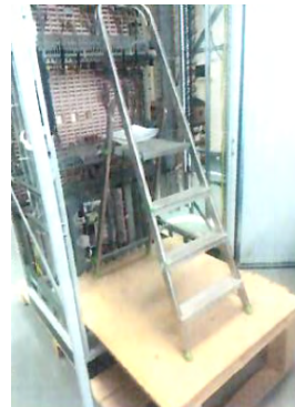
Рис. 2. Изготовление помоста под стремянку для монтажа
