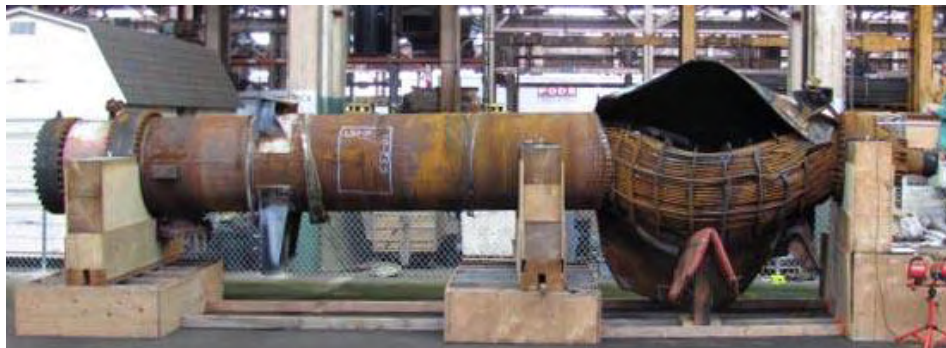
Рис. 4. Разрушение теплообменника в результате водородной коррозии металла корпуса [19]
