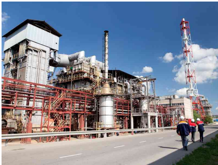
Рис. 1. Установка каталитического риформинга Московского НПЗ [4]
