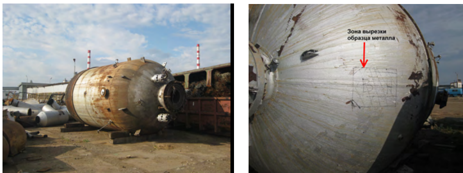
Рис. 8. Подготовка к вырезке образца металла для лабораторных исследований из реактора гидроочистки
