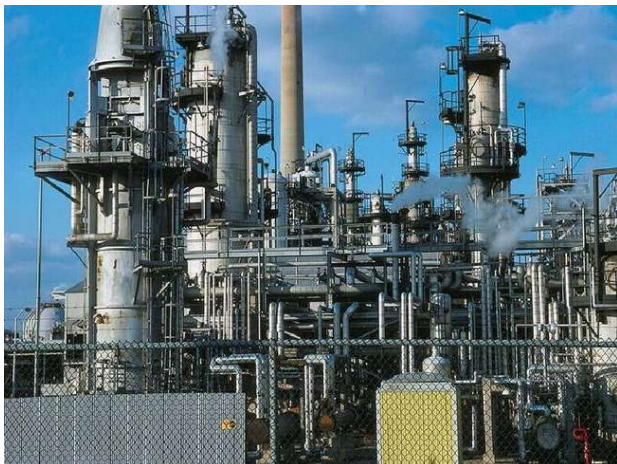
Рис. 2. Строящийся завод глубокой переработки нефти с установкой гидрокрекинга ООО «КИНЕФ» [5]
