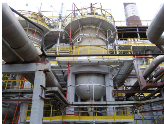
Рис. 6. Реактор установки каталитического риформинга ООО «КИНЕФ»
