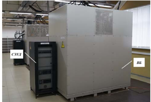
Рис. 1. Модуль СНКЭЭ, состоящий из высоковольтного блока (ВБ) и стойки электропитания, управления и диагностики (СЭУД)
