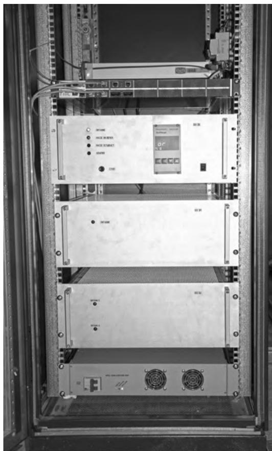
Рис 3. Внешний вид технологической стойки с блоком управления БУ 3м
