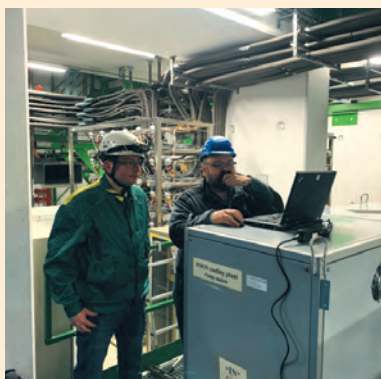
Специалисты РФЯЦ-ВНИИЭФ в шахте эксперимента ALICE: слева – проверка параметров работы системы охлаждения кристаллов PbWO_4 ; справа – работы внутри магнита L3 по проверке герметичности внешнего корпуса модуля
