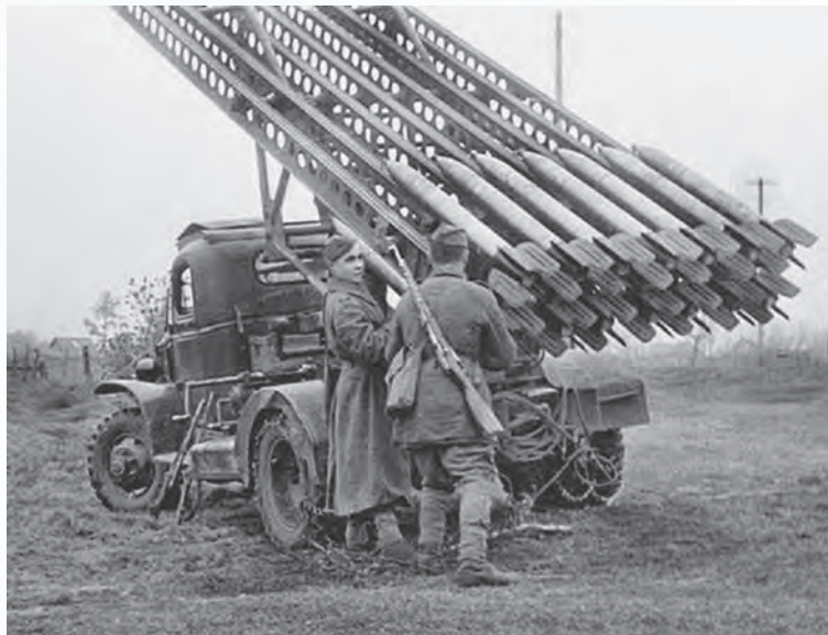
Гвардейский миномет «Катюша» – бесствольная система полевой реактивной артиллерии
