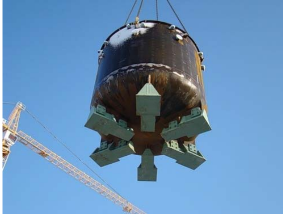
Рис. 1. Фотография корпуса устройства локализации расплава [6]
