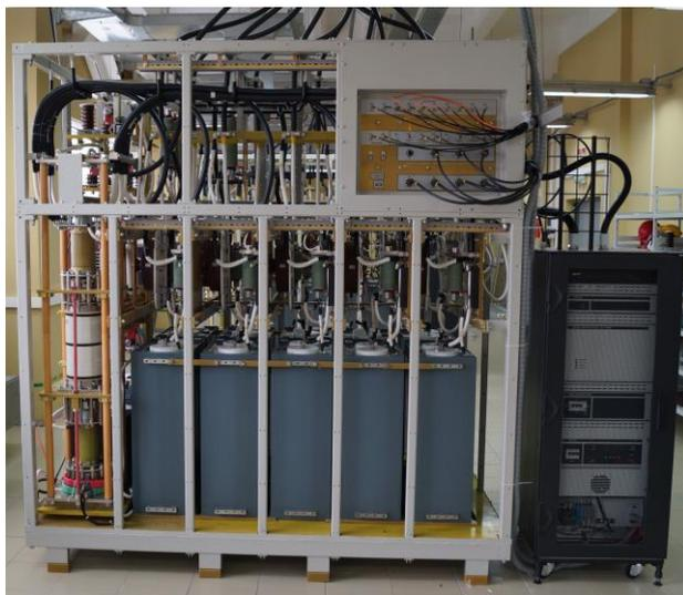
Рис. 1. Общий вид модуля конденсаторной батареи
