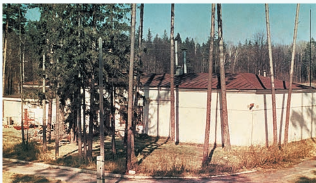
Первое производственное здание реакторной площадки («павильон» – потом «корпус Б»), в котором в помещении казематного типа с мощной биологической защитой – железобетонными стенами и потолком толщиной до 2 м – размещалась первая ЯФ установка – «ФиКоБыН»
