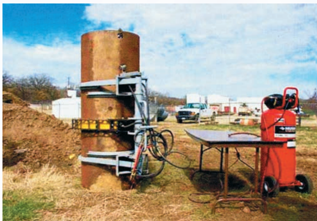
Взрывной резак в рабочем состоянии (масса ВВ ~ 6 кг) (JRC Engineering facility at Alvarado, USA)
