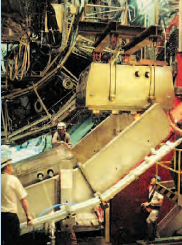
Установка последнего модуля спектрометра PHOS в опорную структуру (фото слева) и трехмодульный спектрометр перед его установкой на рабочую позицию в магнит (фото справа)
